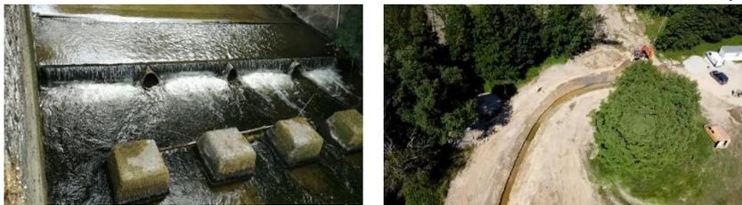
Figure 1 Clapet ne permettant pas la continuité écologique et rivière de contournement
